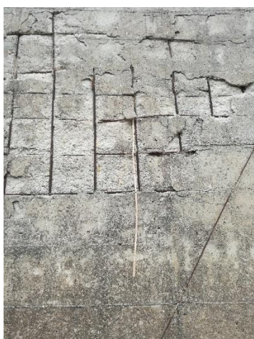
Fig. 18 – Particolare interasse ferri sezione n.2
