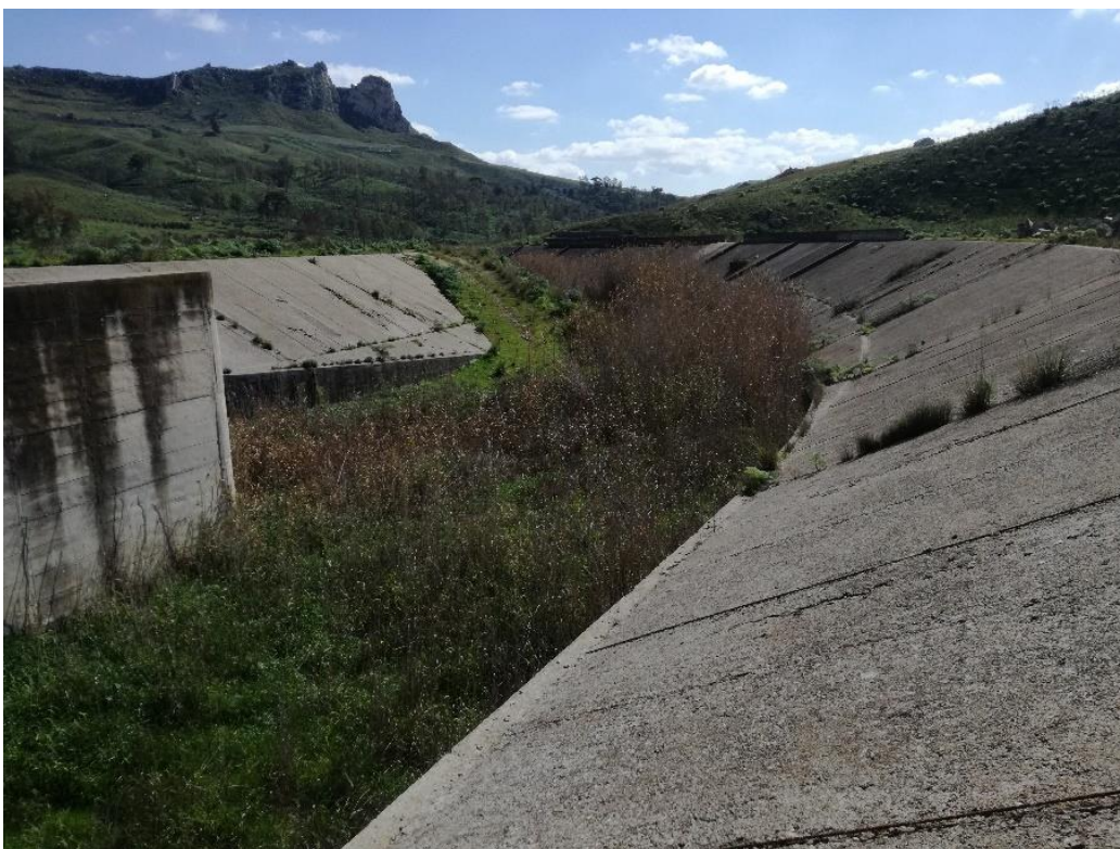
Fig. 55 – Canale di restituzione –fenomeni di smottamenti di terreno in alveo
