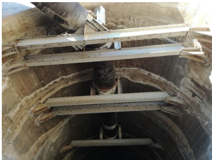
Fig. 39 – Particolare uscita dalla galleria destra del tubo acquedotto.
