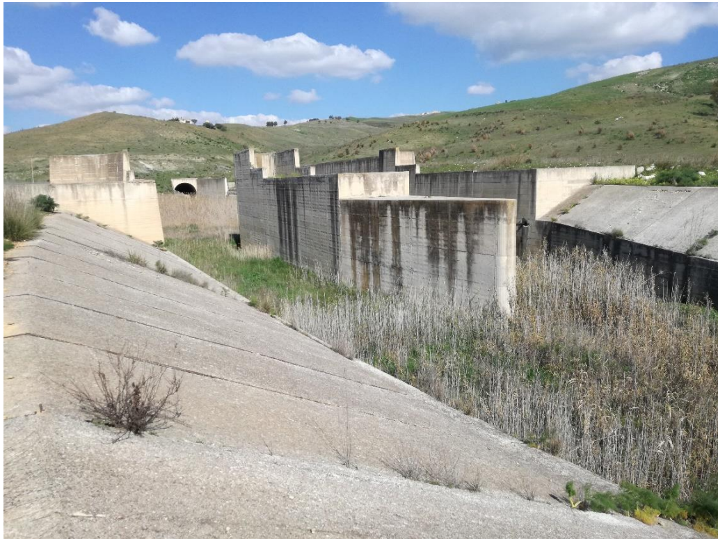
Fig. 54 – Particolare raccordo tra la Vasca e il Canale di restituzione
