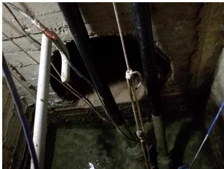
Fig. 35 – Tubo di scarico con particolare pompe di sollevamento acque cariche
