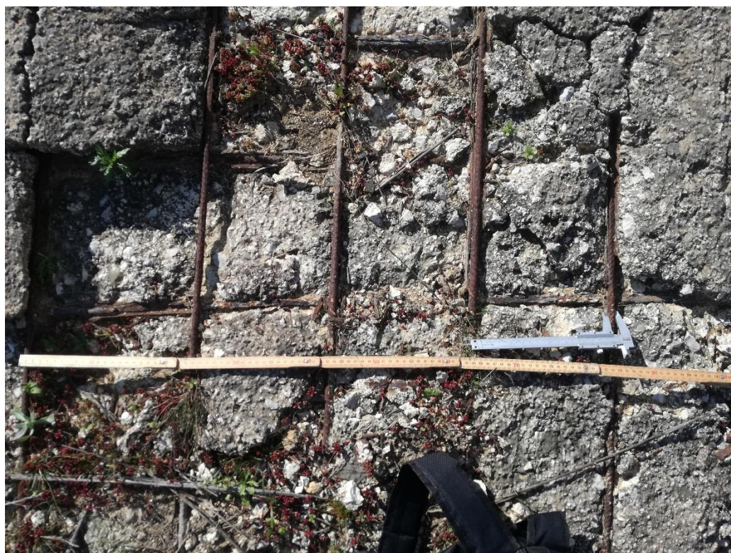
Fig. 57 – Particolare armature ossidate
