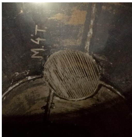
Fig. 46 – Flangia cieca su bocca di ispezione acquedotto
