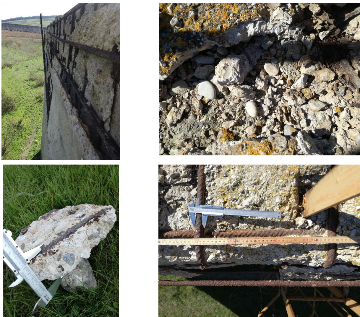
Fig. 9 – Distacchi del copriferro sulle pareti e sul solaio di copertura. In alto a destra particolare della granulometria degli inerti arrotondati
