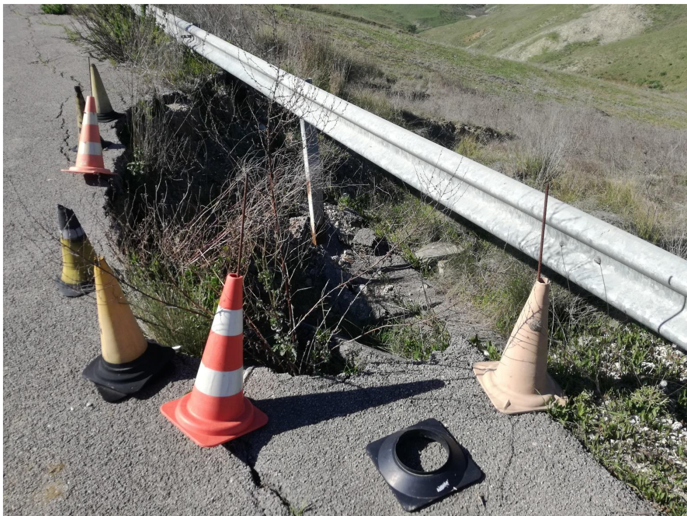
Fig. 20 – Fenomeni di smottamento del corpo stradale
