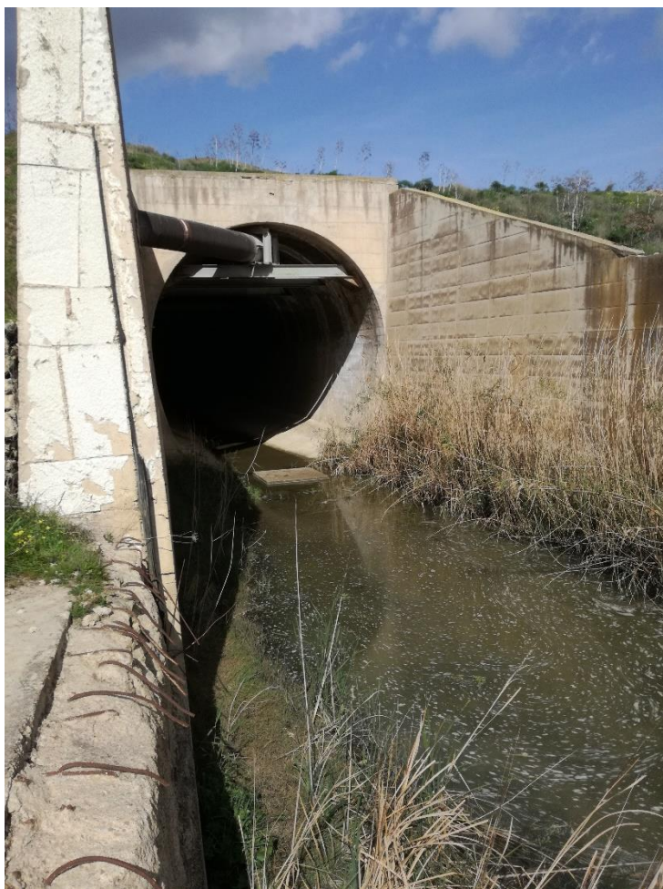
Fig. 38 – Sbocco della Galleria di scarico di fondo nella vasca di dissipazione, con particolare crollo parziale del muro di parete destra della Vasca.
