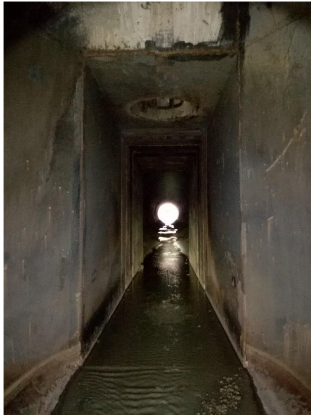
Fig. 45 –Camera paratoie con in alto particolare del tubo aeroforo torre di controllo
