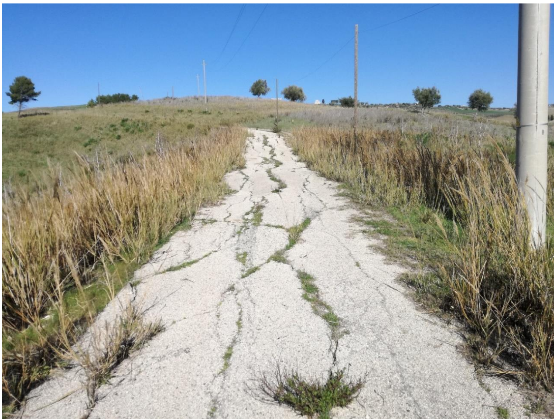
Fig. 21 – Particolare 2 lesioni longitudinali nel pacchetto stradale
