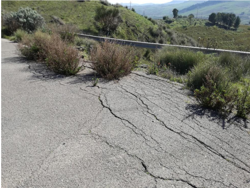
Fig. 22 – Particolare 3 lesioni longitudinali nel pacchetto stradale
