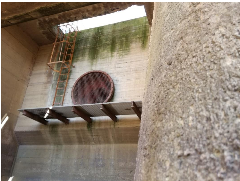
Fig. 4 – Vano principale - Tubo di presa acquedotto
