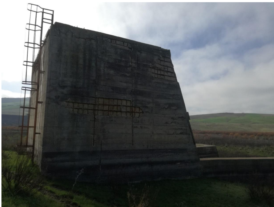
Fig. 2 – Vista lato nord Torre di Presa e Scarico con consistenti crolli del copriferro
