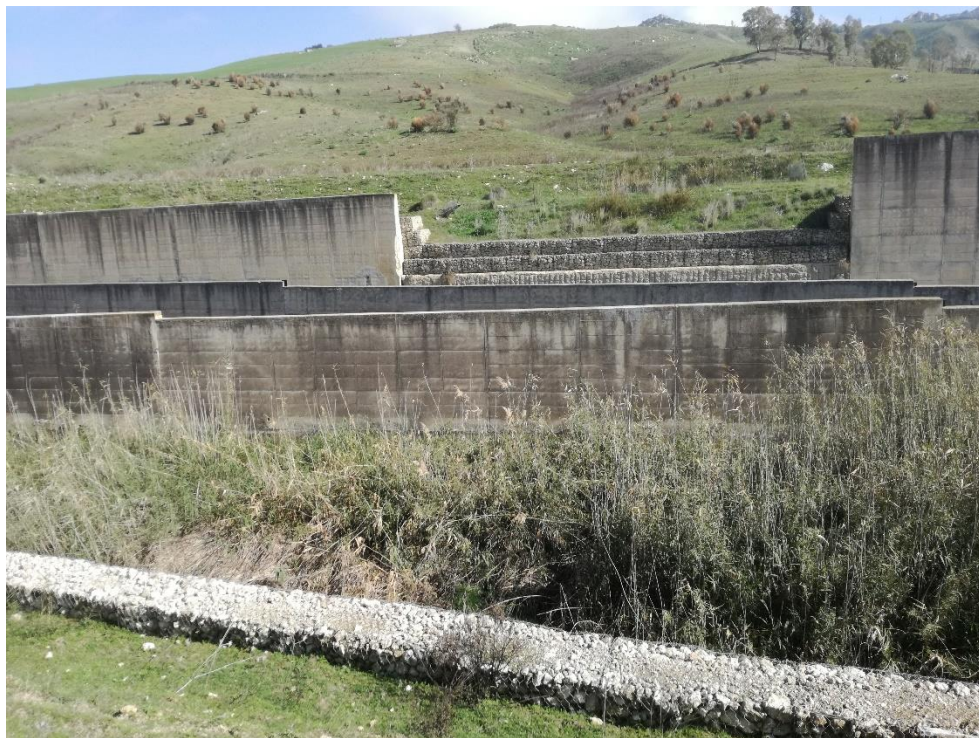
Fig. 52 – Crollo parziale del muro di contenimento di monte della vasca
