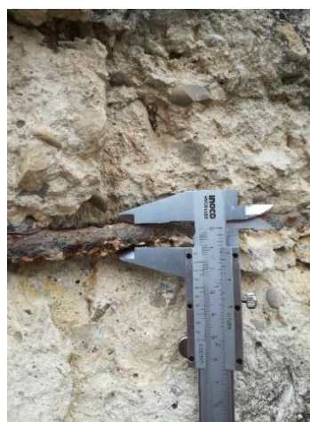
Fig. 19 – Particolare ossidazione delle armature sezione n.2
